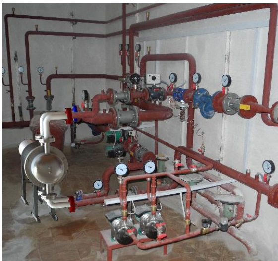
Рис. 5. Испытания нового эффективного теплообменника на основе труб с дискретными турбулизаторами на ТП.
